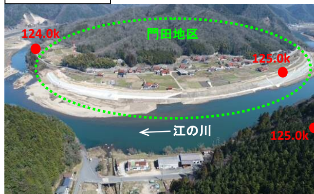
堤防整備状況
