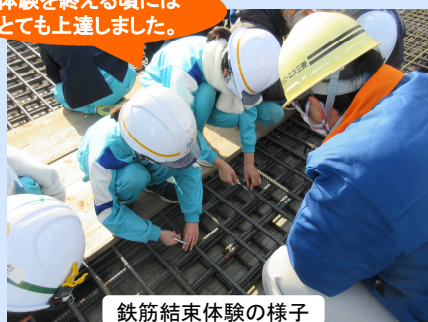
鉄筋結束体験の様子
