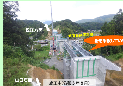
施工中(令和3年8月)
