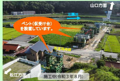
施工中(令和3年8月)
