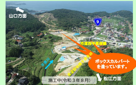
施工中(令和3年8月)
