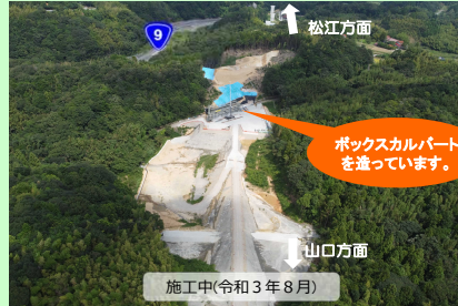
施工中(令和3年8月)
