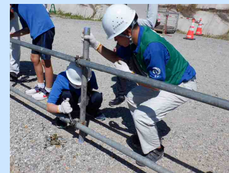
↑単管パイプの組立体験
