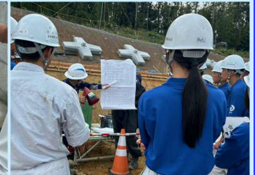
↑法面対策の現場見学
