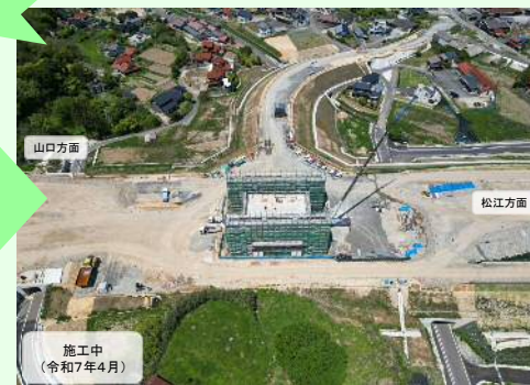
エランプのボックスカルバートを施工中です。
