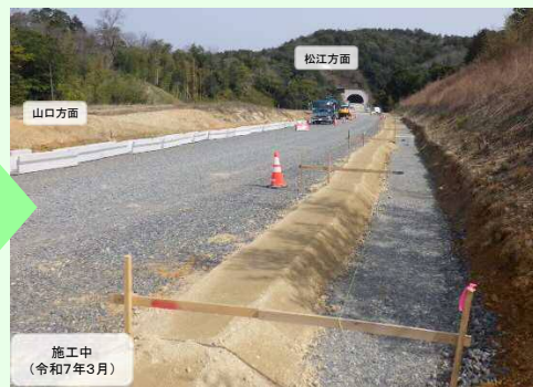
道路横の水路と舗装下の路盤を施工中です。
