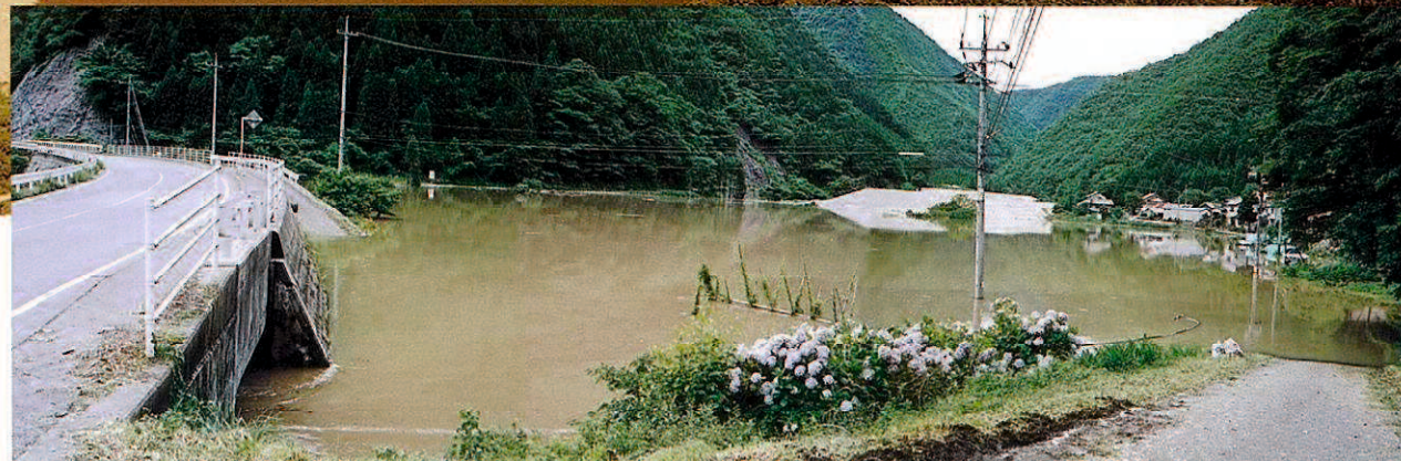
被災状況:坂本地区H7年7月出水
