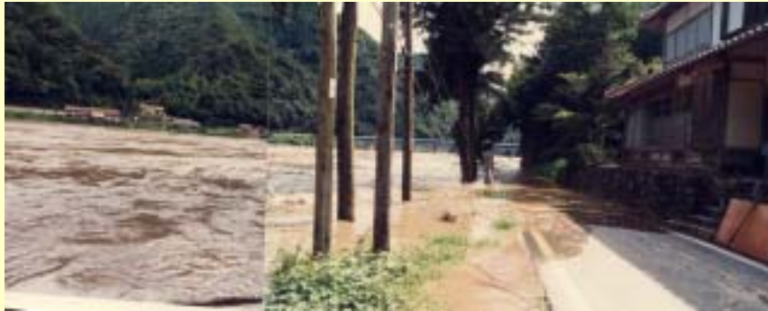
S 5 5 出水状況 (みなと橋下流)
