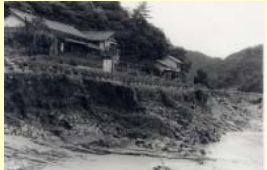
S 4 7 被災状況
