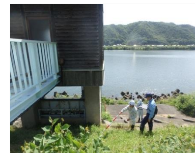
堤防点検状況
