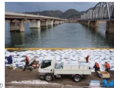
水質事故対応 (オイルマット設置)
