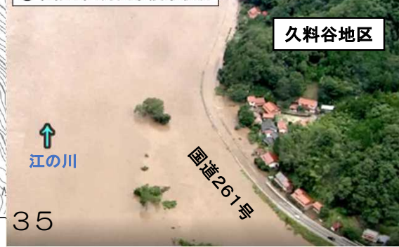
①令和2年7月出水浸水状況
