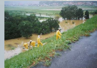
平成9年7月洪水による堤防法尻からの漏水状況
