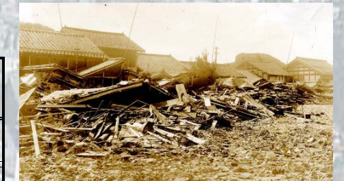
昭和18年9月洪水による益田市街地の被災状況
