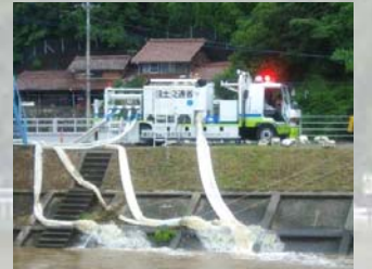
排水ポンプ車の支援活動
