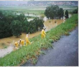
平成9年7月洪水による堤防法尻からの漏水状況
