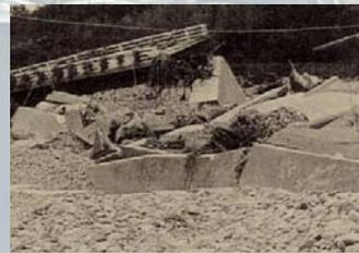
昭和47年7月洪水による虫追橋の被災状況
