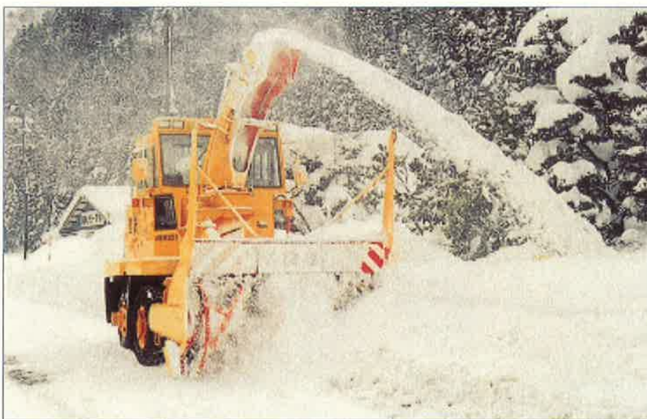
除雪の作業状況
