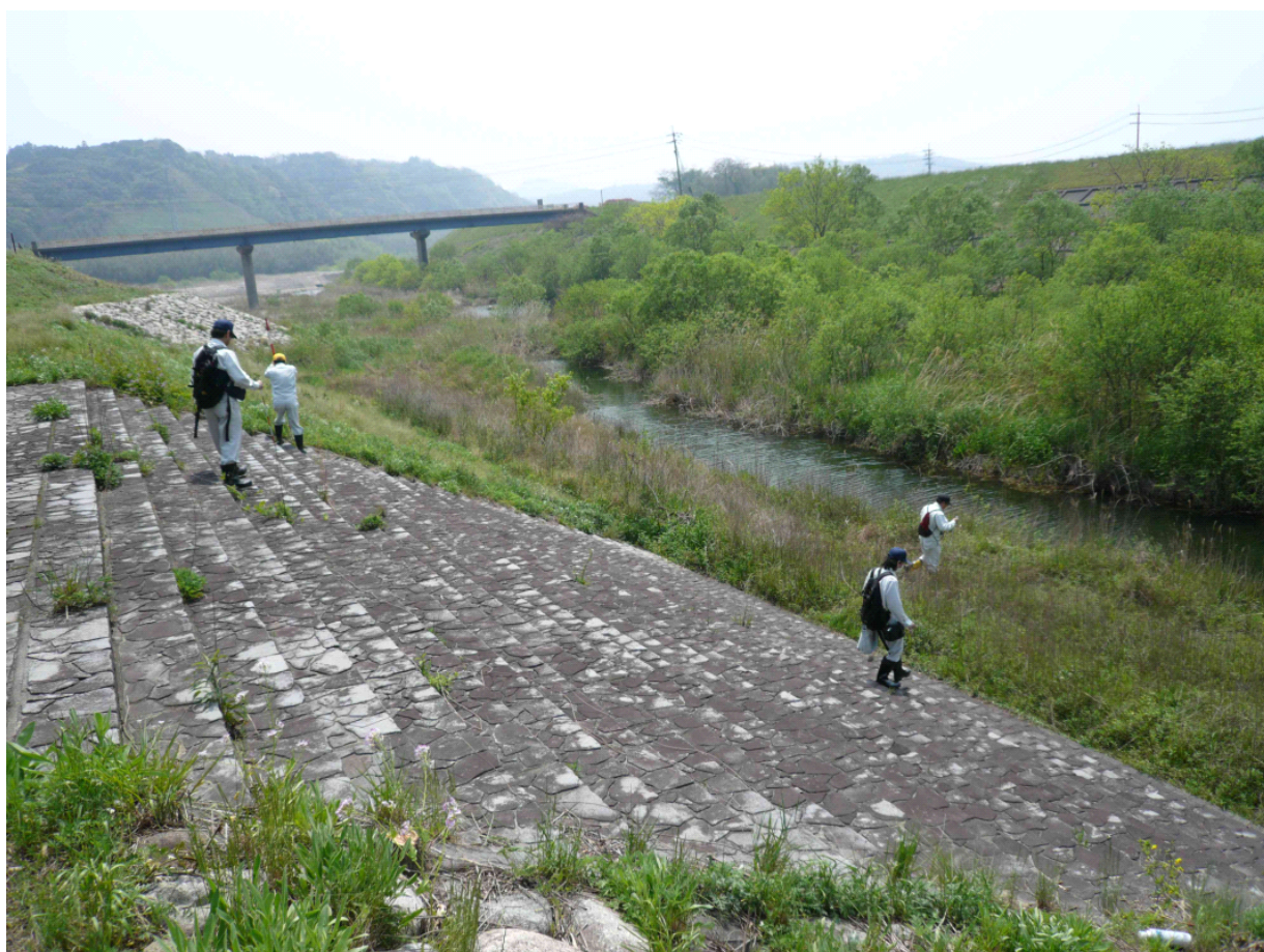
堤防の点検状況
