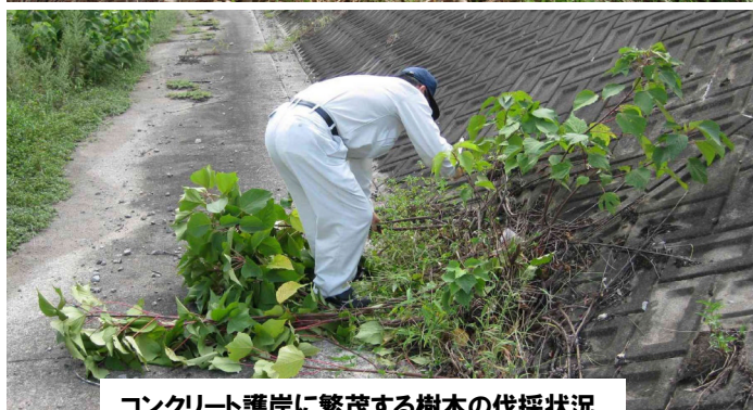
コンクリート護岸に繁茂する樹木の伐採状況 ( 邑智郡川本町上三島 )
