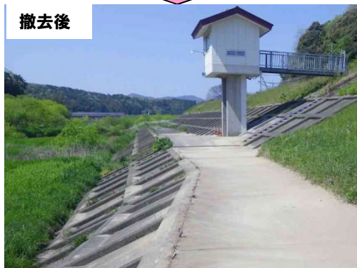
低水護岸の土砂等を撤去した(益田市飯田町)
