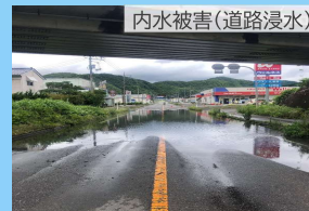
内水被害(道路浸水)
