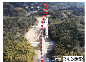
【写真②】土地区の施工状況
