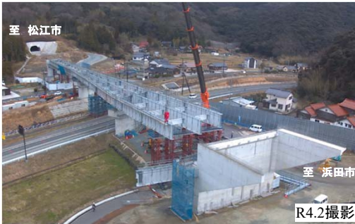
【写真③】静間・仁摩道路 大国高架橋(仮称)付近の施工状況
