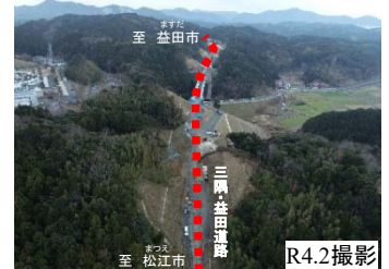
【写真①】古市場地区の施工状況
