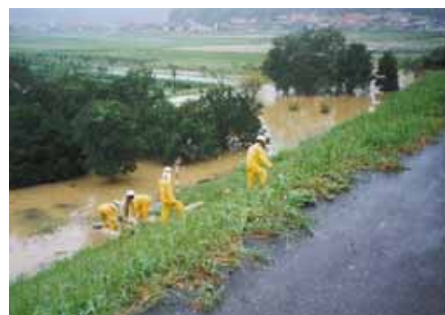
平成 9 年 7 月洪水による漏水状況
