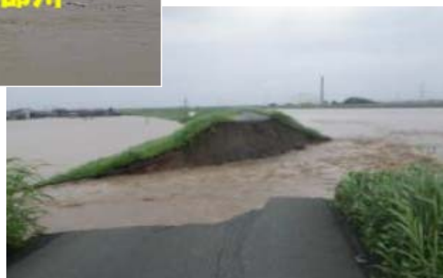
矢部川の基盤漏水による堤防決壊(H24.7.14)
