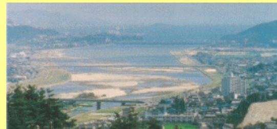
芦田川河口堰の枯渇状況
