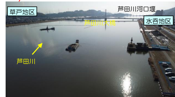
芦田川下流部河道掘削(草戸・水呑地区) (5か年加速化対策による河川改修)
