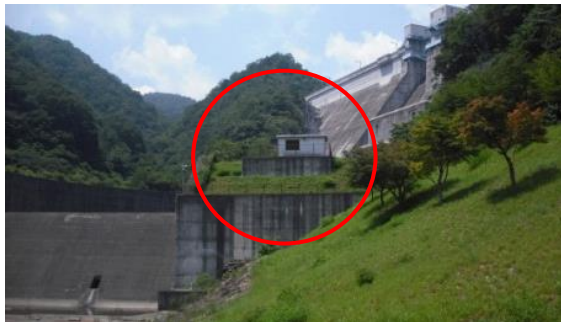
【管理用発電所】
