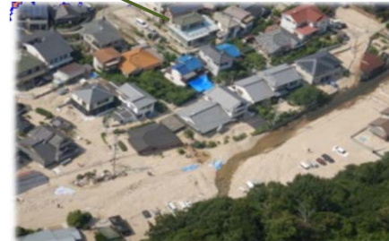
平成30年7月豪雨 (広島県呉市)
