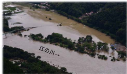
令和3年8月豪雨 (島根県江津市)
