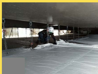
橋梁補修工 （塗装塗替足場工）
