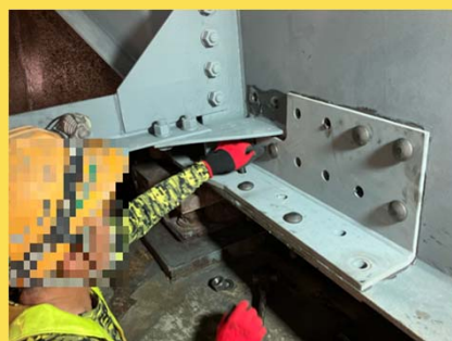
橋梁補修工 （高力ボルト当て板鋼桁補強工）
