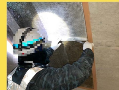
トンネル補修工 剥落防止対策工 （可視繊維シート接着工法）
