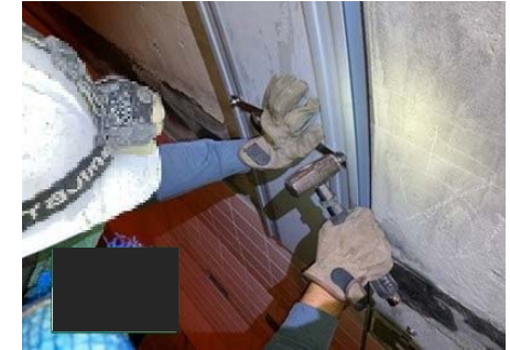
トンネル漏水対策工
