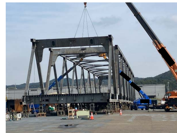
トラス仮組立状況
