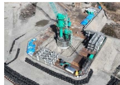
ニューマチックケーソン工
