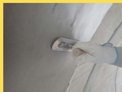
トンネル補修工 断面修復工 （左官工法）
