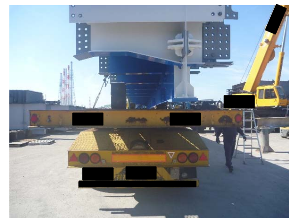
鋼床板鈹桁輸送状況
