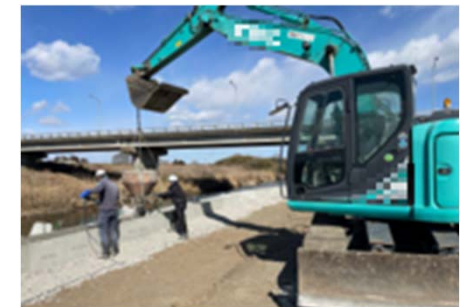
笠コンクリートブロック据付工
