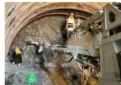
トンネル工（NATM）〔発破工法〕
