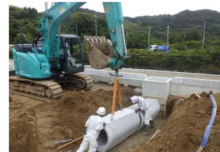
排水構造物工 （鉄筋コンクリート台付管）
