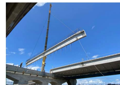
PC橋架設工
