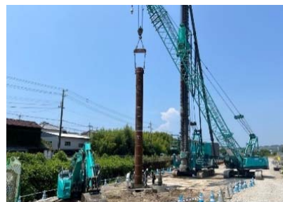
鋼管ソイルセメント杭工
