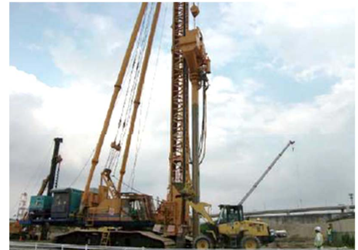
軟弱地盤処理工
