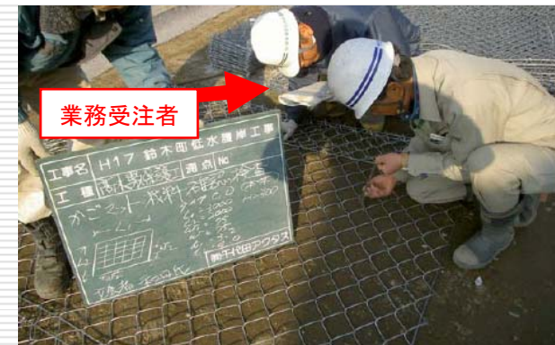
(河川護岸用かごマットの材料確認)
