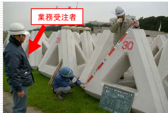
(根固めブロックの材料確認)
