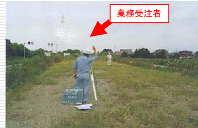
(現場状況の照合を実施)
