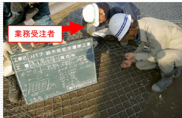
(河川護岸用かごマットの材料確認)
