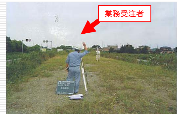
(現場状況の照合を実施)
