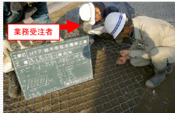
(河川護岸用かごマットの材料確認)
