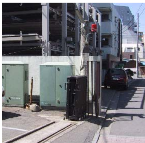
1-2 民地利用方式（地上機器設置）実施箇所例
