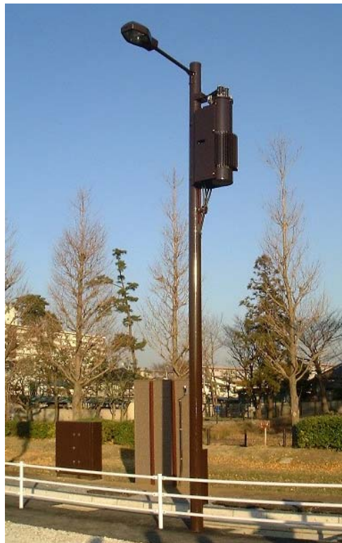
写真 1-4 マルチポール方式実施箇所例
