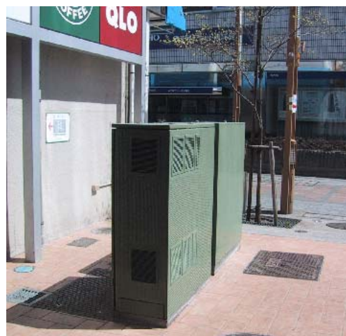
1-2 民地利用方式（地上機器設置）実施箇所例
