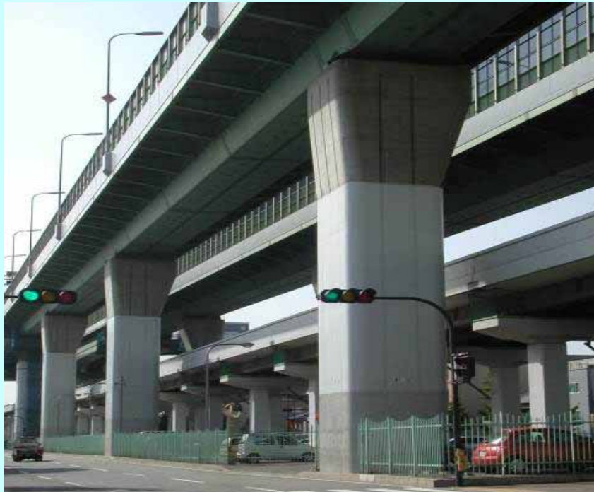
阪神高速道路の橋脚
