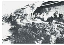
※海岸旅館(清風荘)前の海岸侵食 (昭和15年9月)
