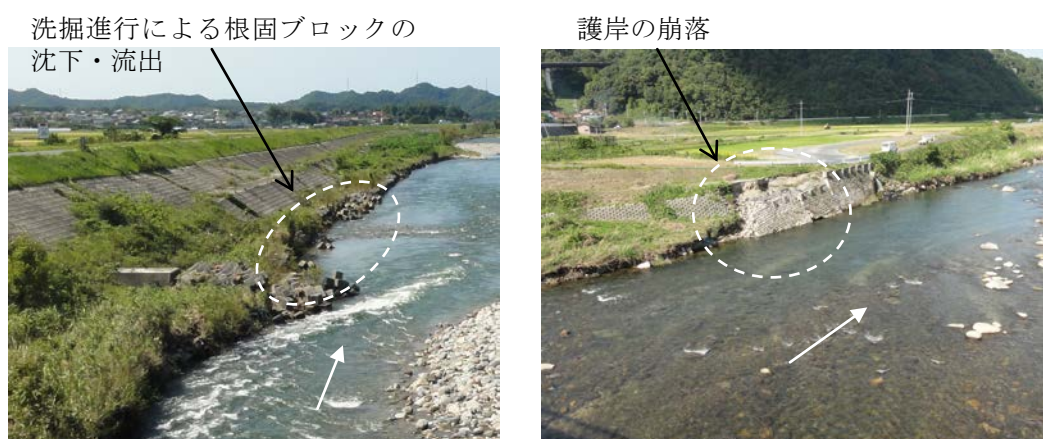
図 6.15 局所洗掘の進行と護岸災害の発生
