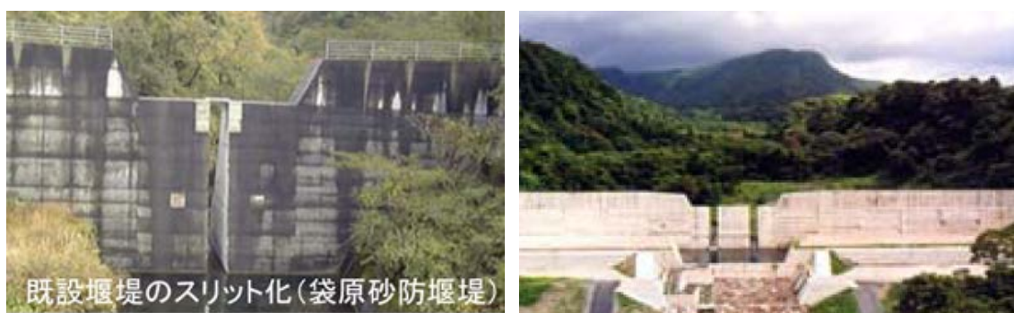
図 6.3 透過型砂防堰堤（左：袋原砂防堰堤、右：栗尾砂防堰堤）
