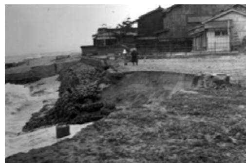
皆生温泉付近の海岸侵食（昭和 30 年）
