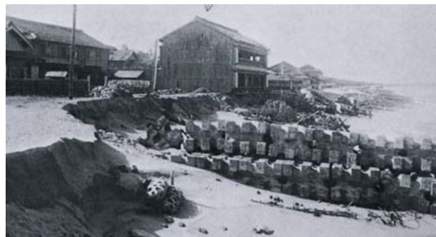
波の犠牲となった金魚亭 (昭和 17 年 2 月)
