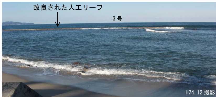
図 6.30 皆生工区の離岸堤と改良された人工リーフ
