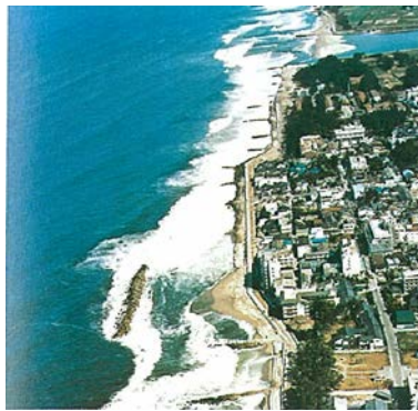
1号離岸堤設置 (昭和46年)
