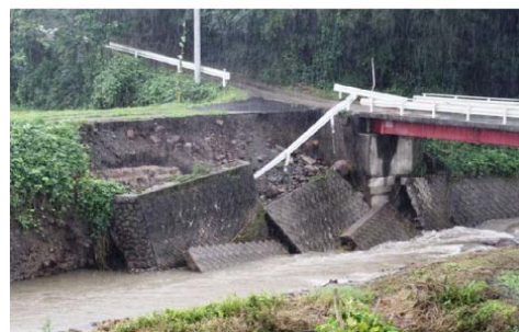
護岸崩壊（別所川、伯耆町久古）
