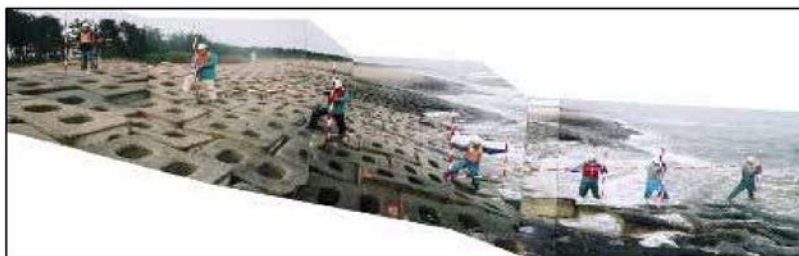
緩傾斜護岸の被害状況 (平成19年1月)
