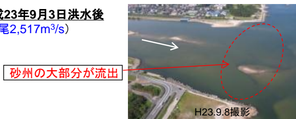
図 6.18 洪水後の河口砂州の状況
