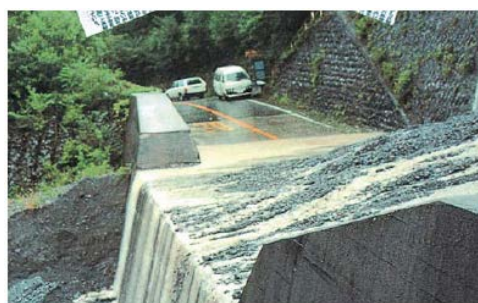
大山環状道路上の土砂堆積
