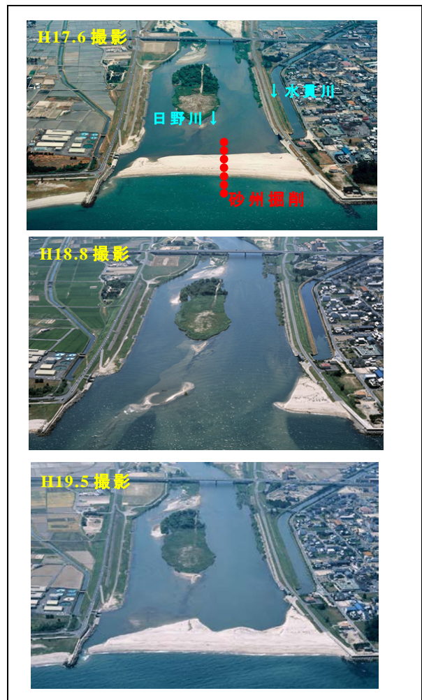
河口砂州 変遷状況
