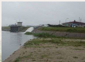
● 皆生排水機場
