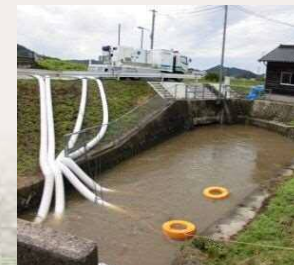
● 排水ポンプ車の排水状況
