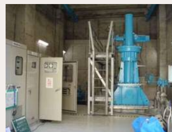
●新設した小規模バルブ
