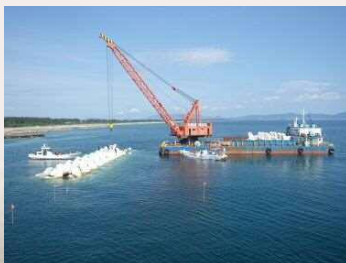
●離岸堤施工状況
