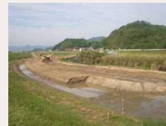
●河床掘削状況
