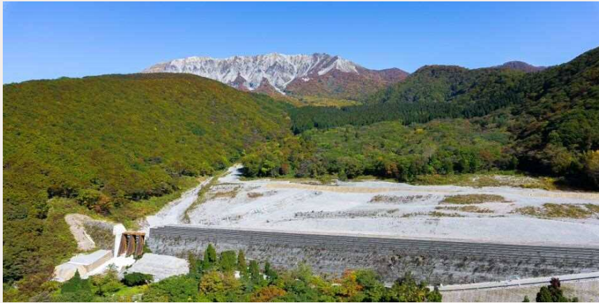
●三の沢砂防堰堤(小江尾川) 平成27年11月完成 * 三の沢砂防堰堤は、堰堤の長さ304mと中国地方最長の砂防堰堤です。
