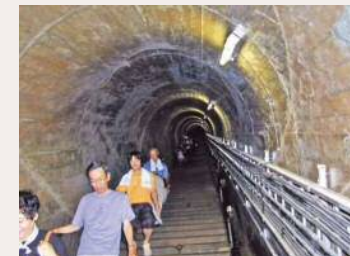
●ダム堤体内部
