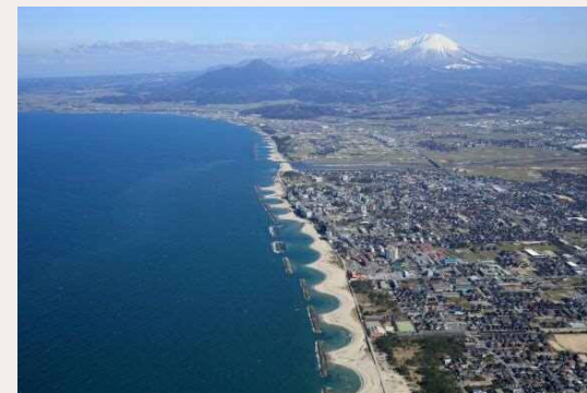
●離岸堤の施工状況(皆生地区)
