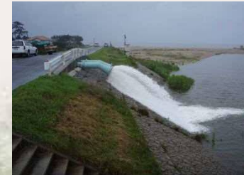
● 皆生排水機場の洪水時排水状況
