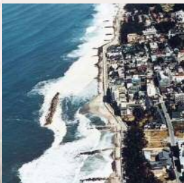
●昭和46年当時の風景 (1号離岸堤完成時)
