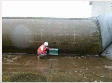
● 日野川堰の点検保守
