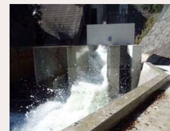
●小規模バルブによる10m 3 /sの放流
