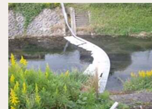
● オイルフェンス設置 (油流出事故対応)
