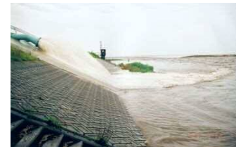
●洪水時の排水状況
