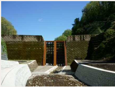
●林ヶ原砂防堰堤(清山川) 平成28年3月完成
