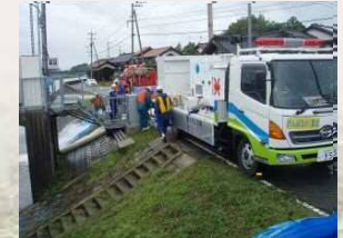
●排水ポンプ出動(米子市青木地区)
