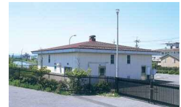
●皆生排水機場
