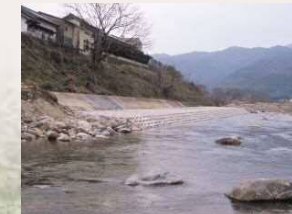
●溝口地先(災害復旧事業)
