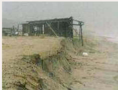
●海岸の侵食状況(富益地区)
