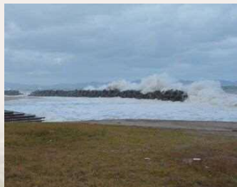
●離岸堤による消波状況(皆生地区)
