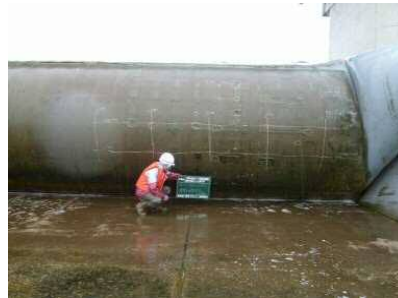
日野川堰の点検保守
