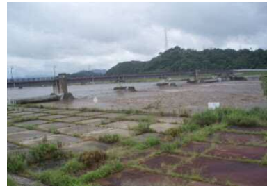
日野川堰の洪水時倒伏状況
