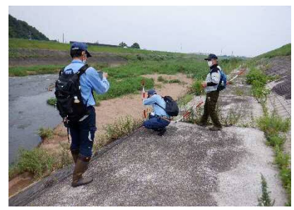
職員による堤防等の点検
