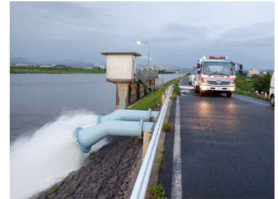
皆生排水機場(救急内水対策)の排水作業
