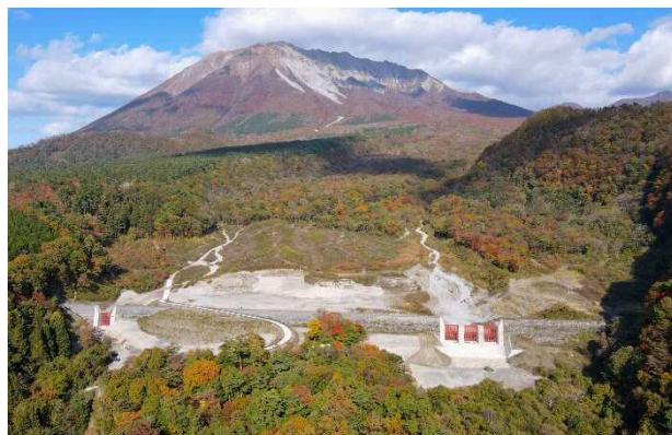
二の沢砂防堰堤
