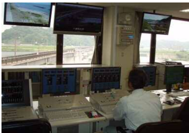
日野川堰の操作
