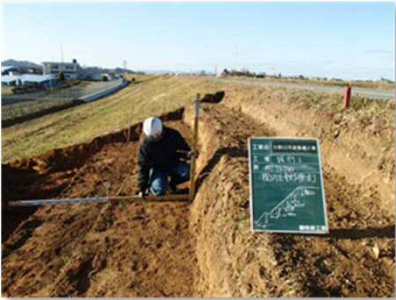
河川工事の監督
