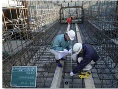
河川工事の監督
