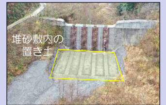
一の沢砂防堰堤の置き土
