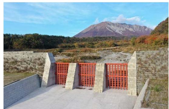
透過型砂防堰堤の例
