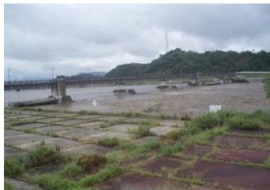
日野川堰の洪水時倒伏状況
