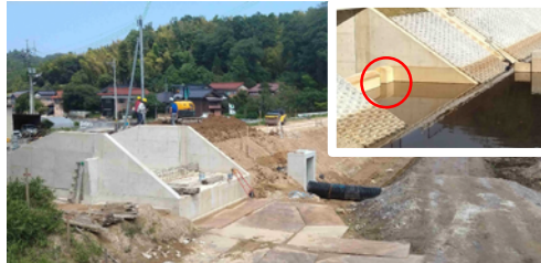
防災重点農業用ため池改修(鳥取県)
