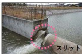
▲スリットの設置状況
