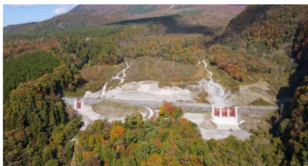
■二の沢砂防堰堤(令和3年完成)
