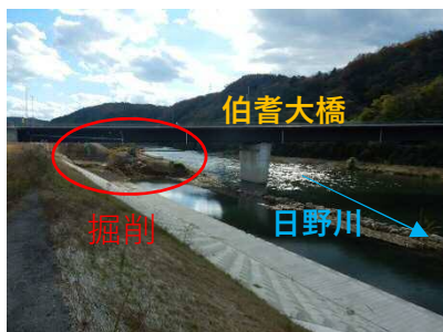
■ 掘削工事の様子
