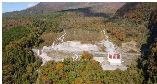
■ 二の沢砂防堰堤(令和 3 年完成)
