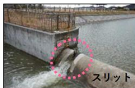
▲スリットの設置状況
