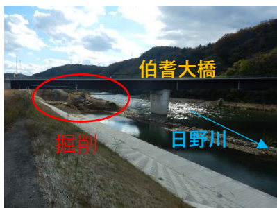
■ 掘削工事の様子
