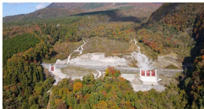
■ 二の沢砂防堰堤(令和 3 年完成)
