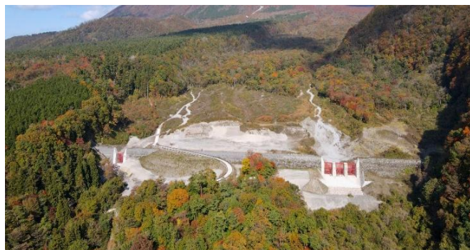
■ 二の沢砂防堰堤(令和 3 年完成)
