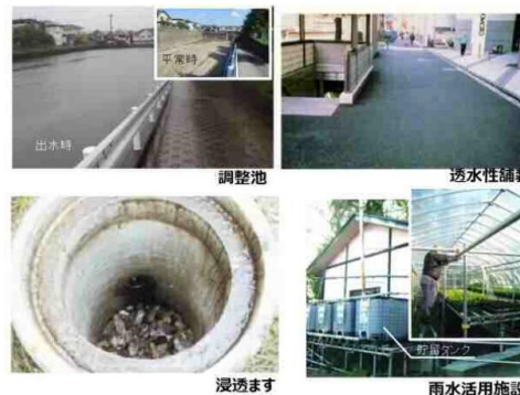
雨水貯留浸透施設の例
