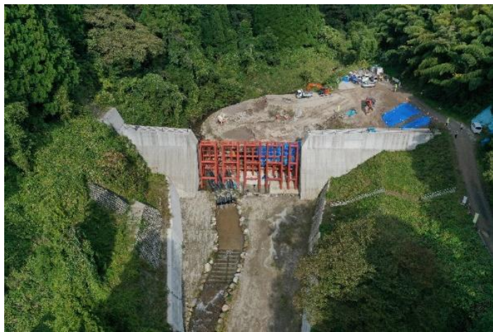
■ 美用砂防堰堤（令和 7 年完成）
