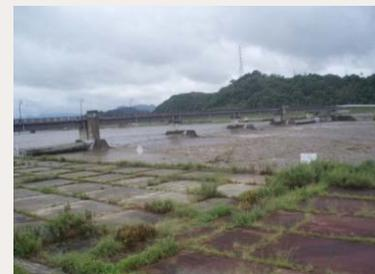
●日野川堰の洪水時倒伏操作
