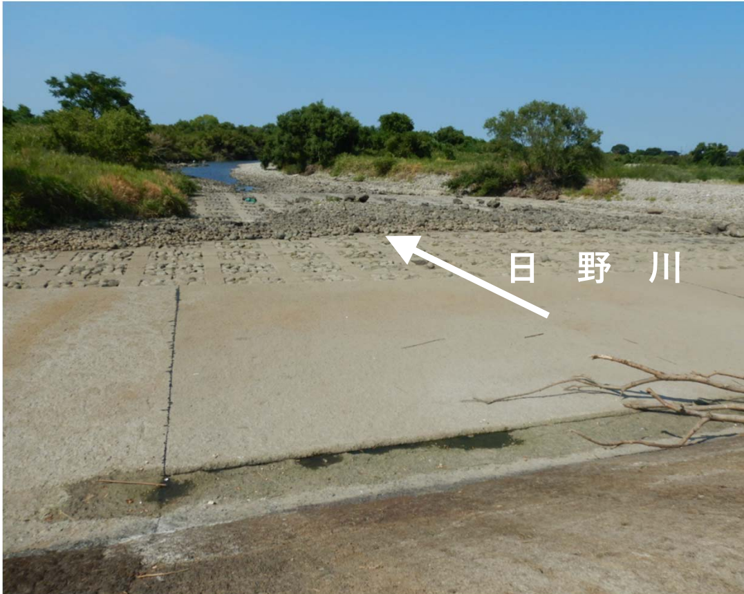
車尾堰より下流側
