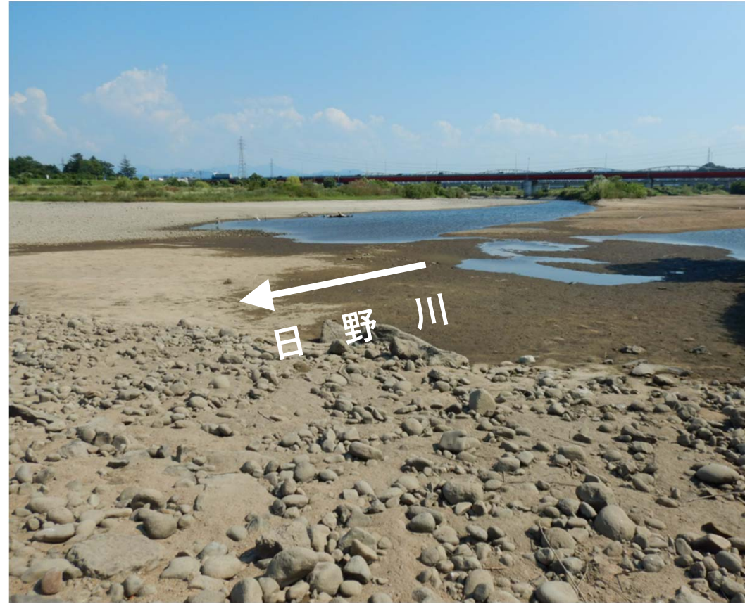
車尾堰より上流側
