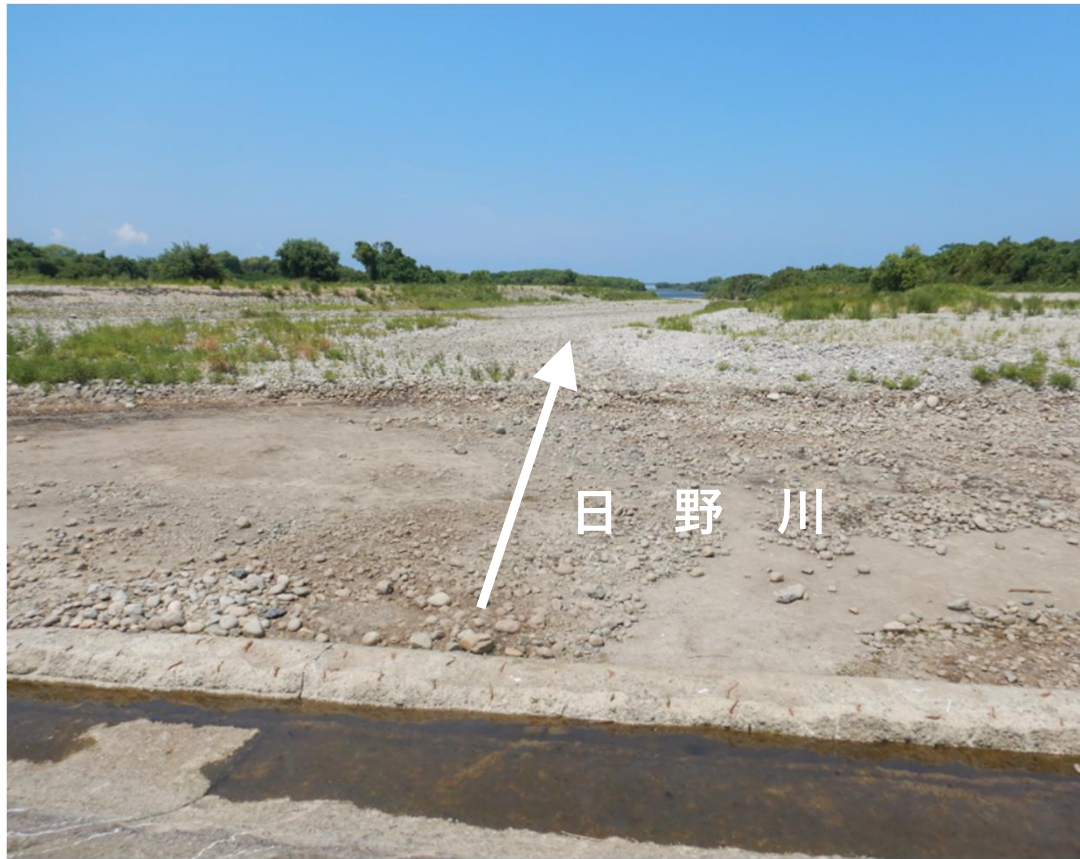
車尾堰より下流側
