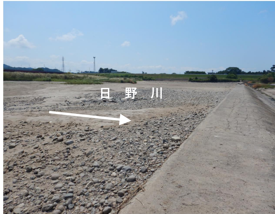
車尾堰より上流側
