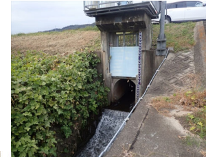
下瀬排水樋管
