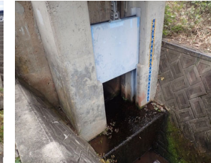
東安寺排水樋管
