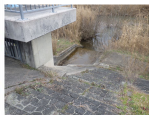
榎原排水樋門
