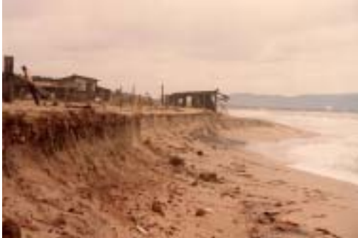
夜見・富益工区 台風来襲時(平成9年)
