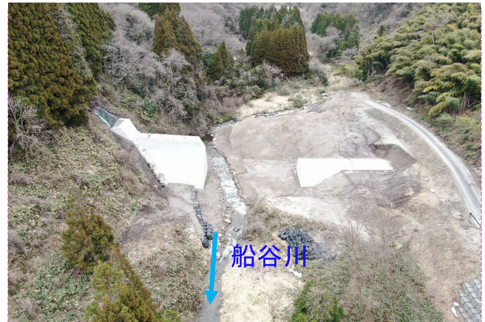
完 成(右岸側本堰堤)
