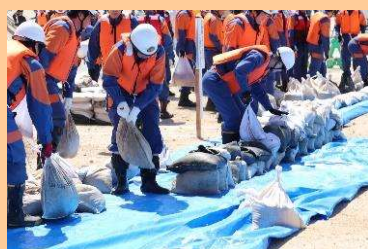
水防団による水防訓練 （改良積土のう工法）
