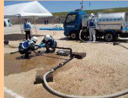
米子市水道局による 配水管応急修繕訓練
