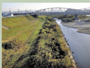
施工前(平成12年11月撮影)
