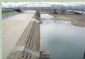
施工後(平成14年3月撮影)
