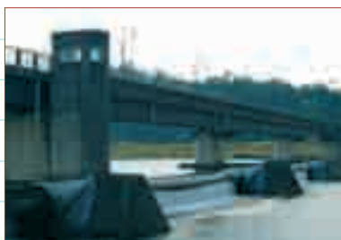
●空気が入った状態で水をせき止めます
